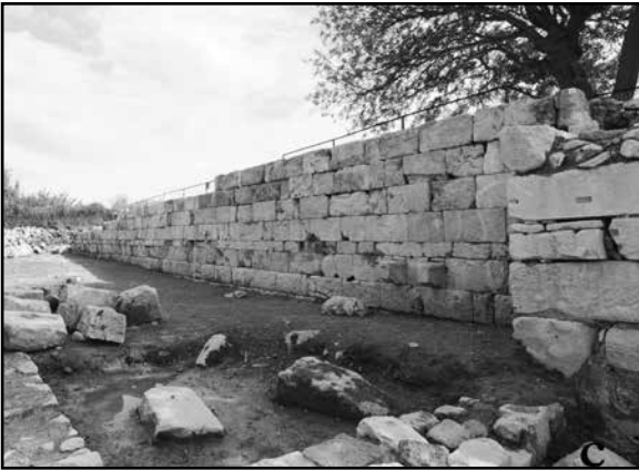
Resim 8c: Restorasyon sonrası, Bouleuterion Batı (Arka) duvarı.
